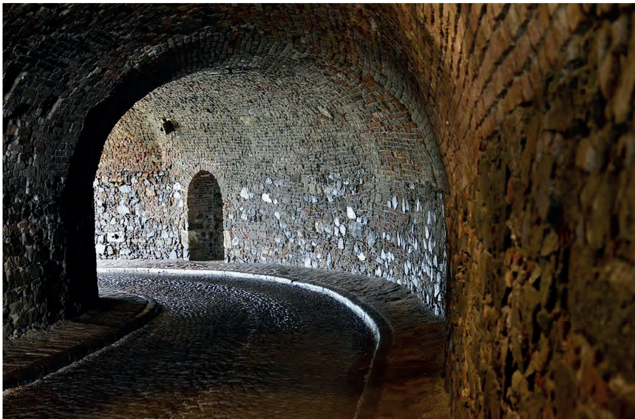
43. kép. Pétervárad (szerbül Petrovaradin) a 18. századi erőd felsővére, a nyugati kapu alagútja. Boltozatának falszövetében a középkori monostorból vagy annak védműveiből származó, fehér kváderkövekkel (Fotó: T. Németh Gabriella) Fig. 43. Petrovaradin, the tunnel of the Western gate of the upper fortress of the 18 th century fort. The wall fabric contains white quadrangular stones from the medieval monastery or its fortifications (Photo: T. Németh, Gabriella)
